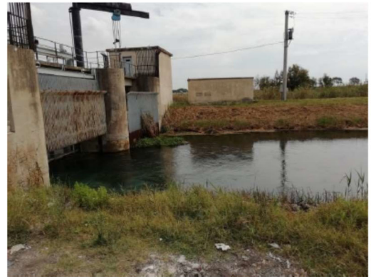
Sbarramento lungo il F. Tara
